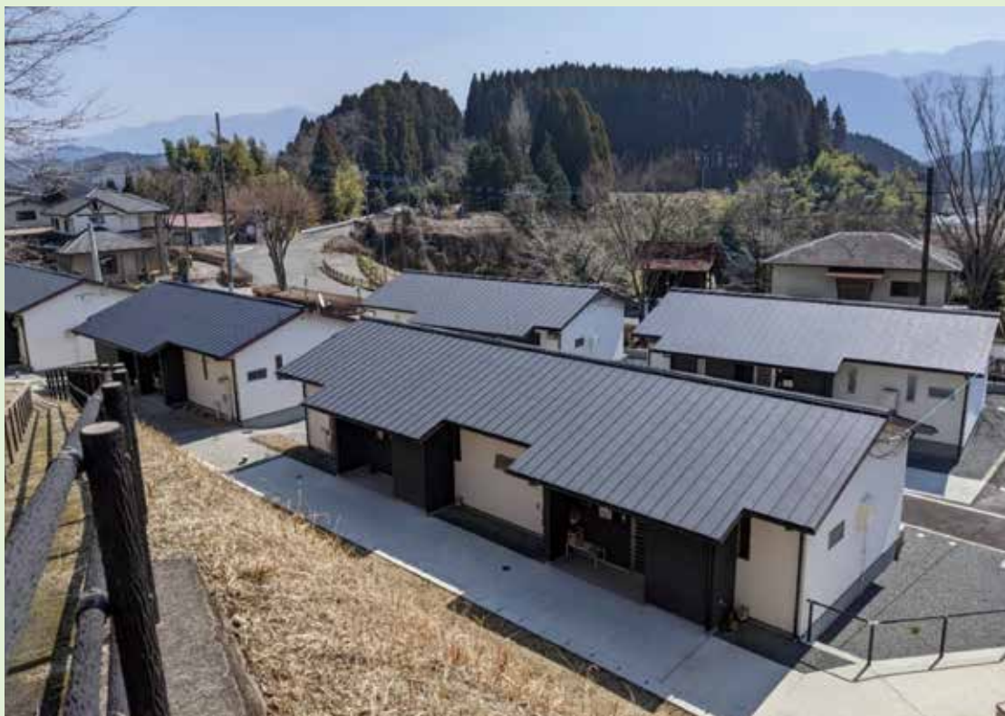
美里町と御船町から山都町に移設され、復興支援住宅として活用されている事例。（熊本県山都町、写真提供：熊本県庁）
