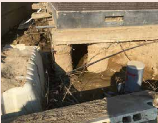
fig.5 水流で地面が削られ露出した建物基礎：地盤改良（柱状改良）の跡からかつて低地の農地を宅地開発したことが窺える(提供：中村陽二氏)
