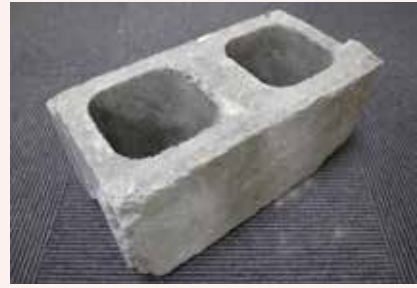
fig.2 被災者が現地で練り固め積み上げた二穴コンクリートブロック (H190 × W390 × D190mm) : 施工がしやすいように二穴が採用され、穴には断熱材として新聞紙などが詰められた (提供: 堀田典裕)
