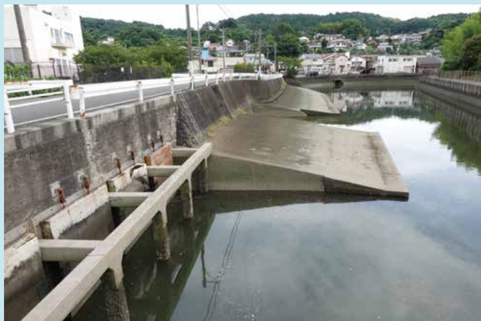
fig.8 手前の排水口が百間排水口。右手に広がっていた百間湾に工場排水を排出していた。湾の大部分は埋め立てられ、エコパークとなっている（撮影：会誌編集委員会）
