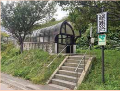
fig.5 島内42カ所に避難路が設置された。写真はドーム式避難路。中はスロープで青苗地区の高台までつながっている（撮影：会誌編集委員会）
