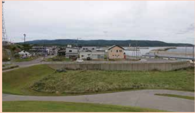
fig.4 慰霊の丘から青苗地区を臨む。6mの防潮堤に合わせて、土地が嵩上げされ、その上に住宅が再建された（撮影：会誌編集委員会）
