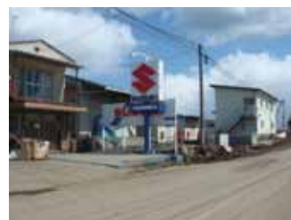
写真1 建物は無被害
