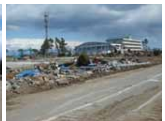
写真2 荒浜小学校付近では木造全壊
