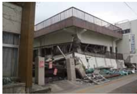
写真2 RC造建物の倒壊(仙台市若林区卸町)
