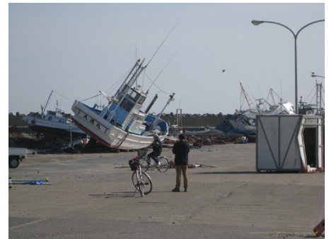
大洗港の津波被害 茨城県東茨城郡 [撮影:秦 一平]
