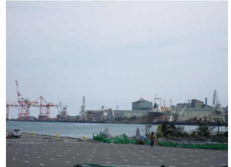
港の護岸は波を打ち、対岸ではコンテナ船らしい物が 乗り上げている 宮城県仙台市 [撮影:永野 聡]
