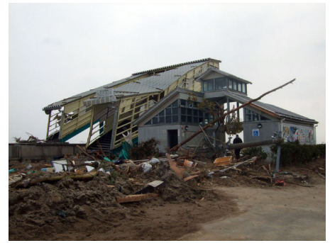
津波の被害にあった山元町坂本駅。駅前の住宅は壊滅 宮城県山元町 [撮影:鈴木孝男、2011.3.25]
