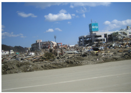
すべてが瓦礫とした陸前高田市の中心部の様子。 3階建てのビルの3階部分が透けて見える 岩手県陸前高田市 [撮影:佐藤隆雄、2011.3.28]
