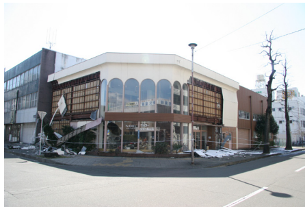
応急危険度判定により全壊の赤紙が貼られている 宮城県仙台市若林区卸町界隈 [撮影:永野 聡]
