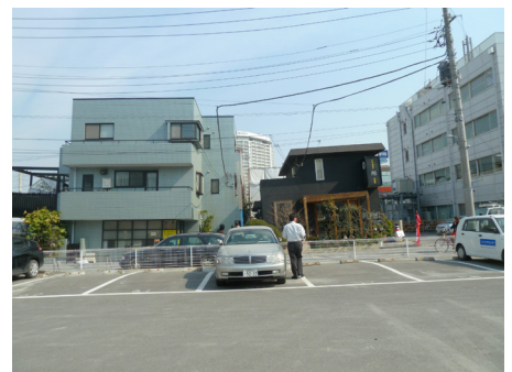
左右両建物が中心部へ傾く 千葉県浦安市入船地区 [撮影:岸田忠大]
