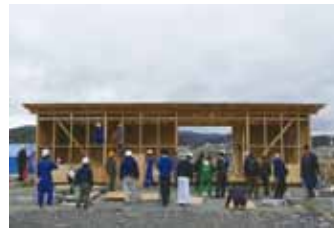
写真12 3日目:外壁および防水工事
