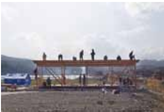
写真11 2日目:屋根組み
