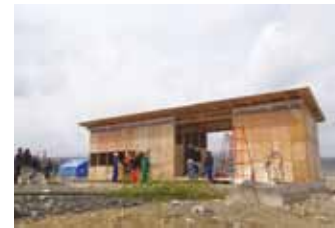
写真13 4日目:建具工事
