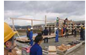
写真10 1日目:躯体組み
