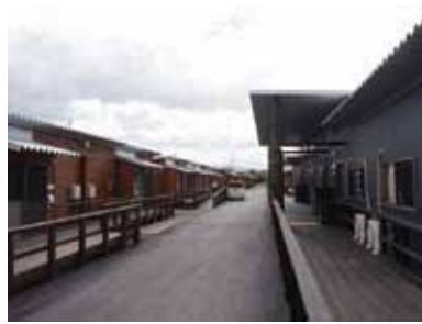
写真8 福島県の木造GH型仮設事例(本宮市)。左手は一般仮設住宅、右側がテツキを持つGH。浪江町の認知症高齢者GHが入居(事例2)
