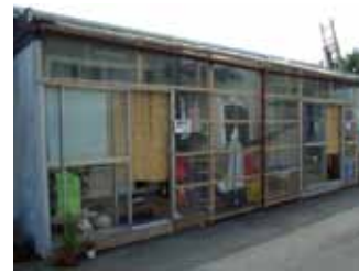
写真11 風除室の大型化(中越)
