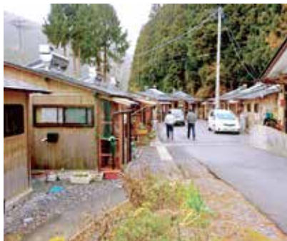
図4 木造仮設住宅外観。増改築の様子
