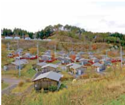
図3 陸前高田市オートキャンプ場モビリア内の木造仮設住宅
