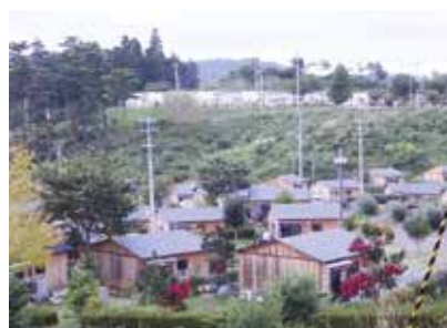
図2 戸建て木造仮設住宅。高台に見えるのは従来型の仮設住宅
