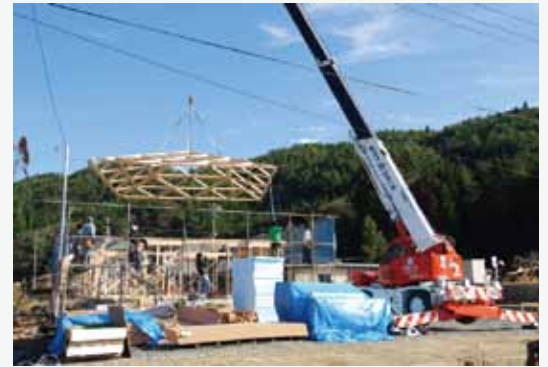
図5 | 建設2日目【撮影：松岡研究室】
