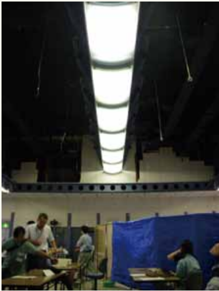
図1 | 調査拠点の様子。大量の人と申請に対応するため昨年末まで庁舎講堂を利用。その間、天井・壁は崩落したままの状態であった[筆者撮影]
