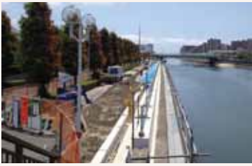
図4 | 境川護岸堤防の本格復旧工事現場
