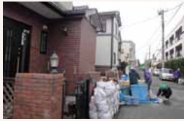
図5 | 市内の被災戸建住宅地の各所で急ピッチに進む沈下修正工事風景、修正工事の進捗率は町内会ごとに大きく異なっている
