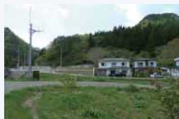
図3 | 造成完了間近の松前沢地区住宅団地。右側は既存住宅(2013年5月)
