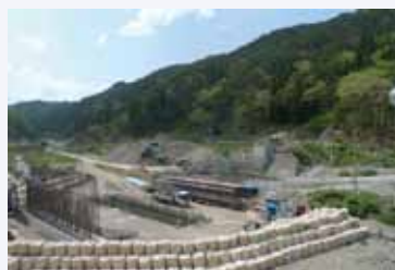
図5 | 盛土工事中の三陸鉄道島越駅予定地周辺(2013年5月)
