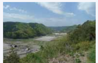
図6 | 防潮林のあった明戸地区。手前から破壊された防潮堤(災害遺構とする予定)、土砂の仮置き場、鮭鱈化場、キャンプ場(2013年5月)
