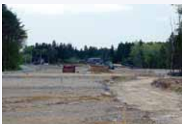
図4 | 造成の進む切牛地区住宅団地。奥は既存住宅(2013年5月)
