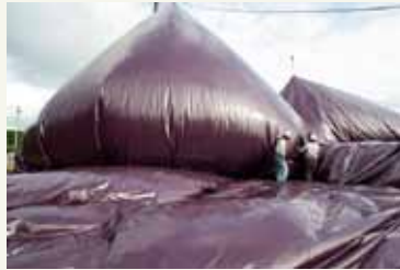
図4 | インフレート時の現場写真。空気を入れて2時間弱で形が立ち上がる
