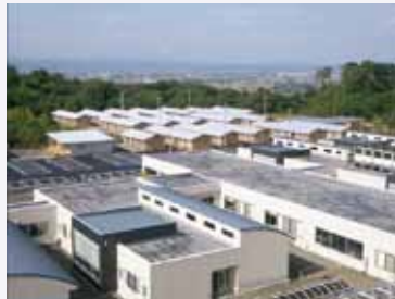
図2 | 周辺風景と溶け込む木造仮設住宅
