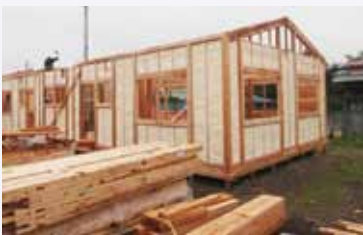
図5 | 木造仮設住宅の断熱仕様例
