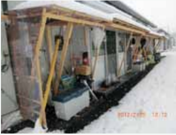
図6 | 仮設住宅の大工らによる柵や雨除けの設置。住民同士の工夫による住環境の改善
