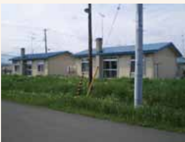
図2 | ストック活用のモデルとした公営住宅[撮影:丸田絢子]
