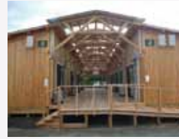
図5 | 遠野市仮設住宅。玄関が向かい合い屋根付きデッキが敷かれたケアゾーン
