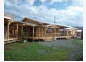
図6 | 遠野市仮設住宅サポートセンター
