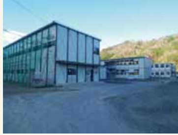
図4 | プレハブで建てられた小中学校
