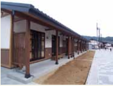
図5 | 完成した災害公営住宅(大ケロ1丁目)
